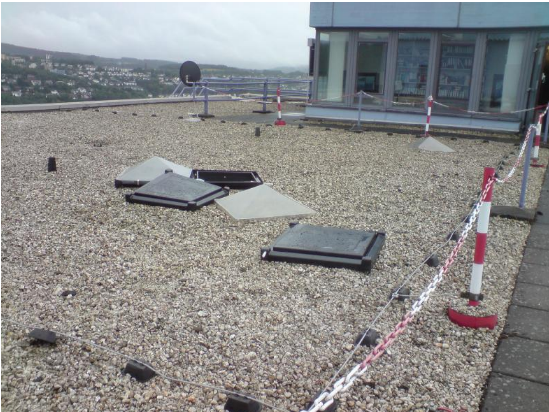
Abbildung 44: Sturmschaden Sunwater-Factory trotz Anbringung einer Sturmhalterung (eigene Darstellung)
